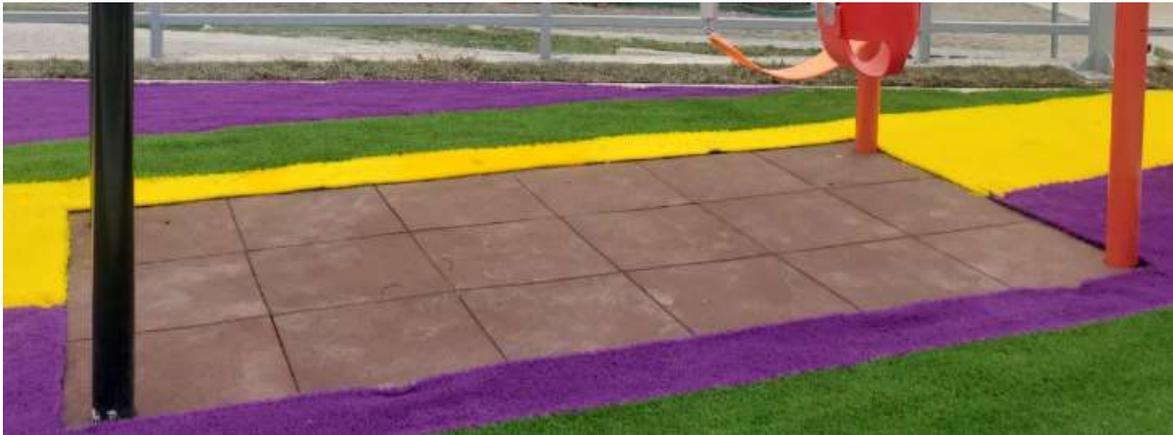
Se debe preparar un firme de concreto simple de 2000 PSI de 5.00 cm de espesor sobre una cama de material selecto con espesor de 5.00 cm como base de instalación para el caucho. Calculando que el nivel de piso terminado del caucho instalado sea igual que el firme de concreto pintado del área de juegos.
