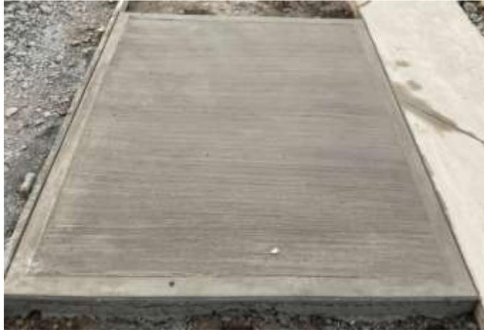
**3.26 REPELLO EN ELEMENTOS CON MORTERO 1:3 (e=2.00 cm).**
