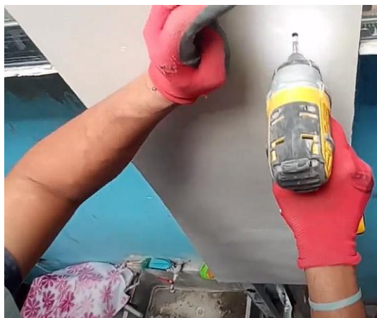
Fig. 3.33.1 – Ejemplo de instalación de lámina de Durock
