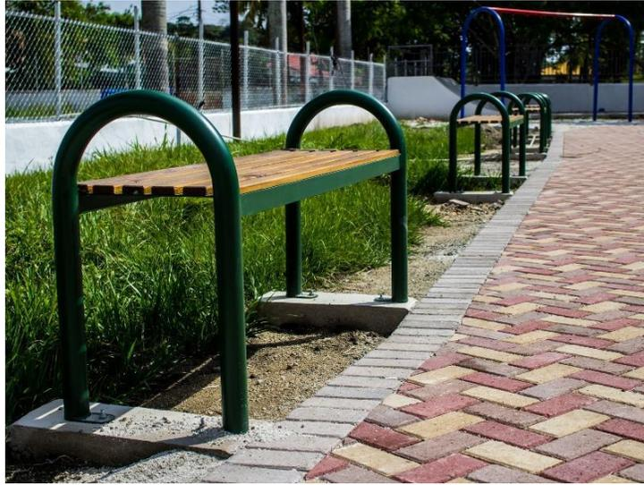
**BANCA METALICA:** Estructura fabricada con tubo metálico de 2" doblado en dobladora industrial, asiento de madera con 6 reglas de madera curada de 1x3 atornilladas sobre ángulos de 2". Estructura cubierta con una mano de anticorrosivo y luego una capa de pintura *Fast Dry*. Montada sobre dados de concreto y sujeta con expansores. Ver imagen
