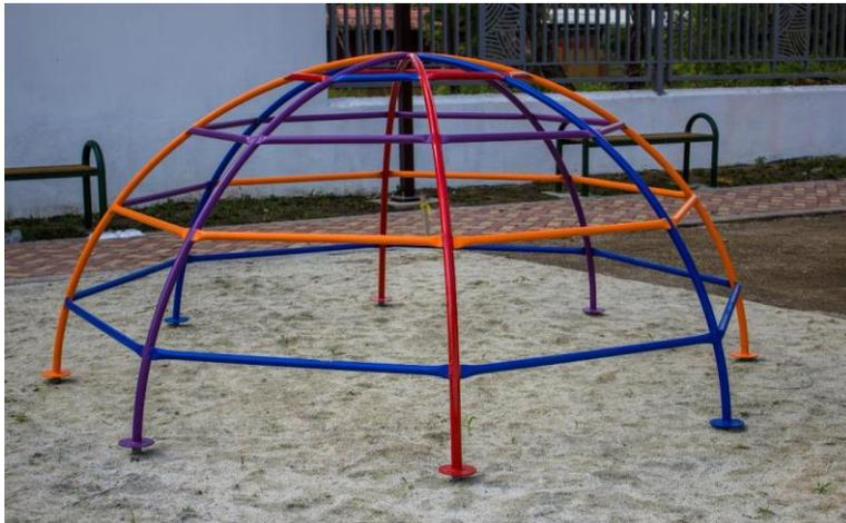
**DOMO METALICO PARA ESCALAR:** Estructura metálica formada por tubos circulares de 1-1/2" cedula 40. Estructura formada por 8 apoyos verticales y 4 líneas de tubos horizontales en disminución. Todos los elementos serán unidos con soldadura según imagen. Los apoyos serán enterrados (no fundidos) para fijar estructura.
