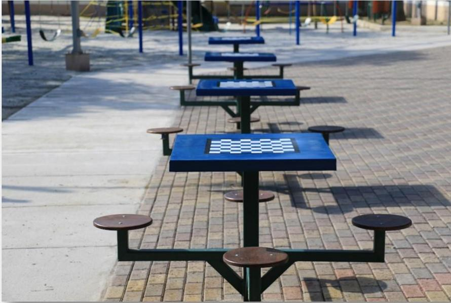
**MESAS DE AJEDREZ:** Estructura metálica formada por tubos cuadrados de 2" chapa 11, 4 asientos de metal, diámetro de asiento de 8", espesor de 1". Tablero de lámina de hierro espesor de 1/8" con medidas de 60x60 cm, montada sobre estructura de metal. La estructura estará montada sobre placa metálica de 20x20 cms y espesor de 1/4" y fijada con expansores para concreto. Ver imagen
