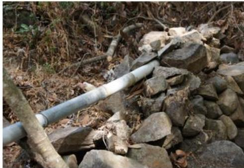
Detalle de falta de anclajes en Línea de Conducción
