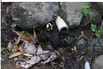
Detalle de tuberías de rebose en mal estado
