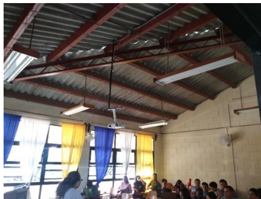
Fotografía No. 3. Aula en Edificio N° 2
