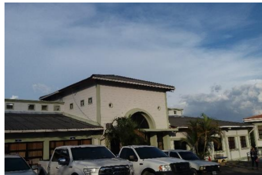
Fotografía No. 6. Edificio N°3
