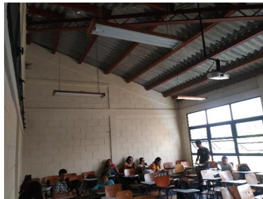
Fotografía N° 2. Aula en segundo nivel del Edificio N° 1
