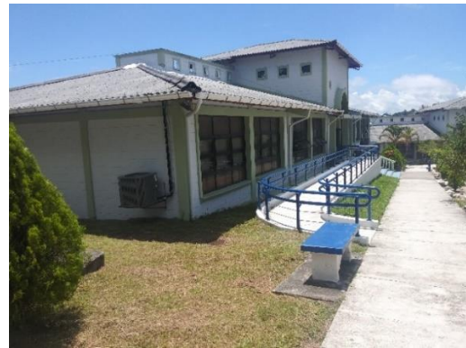
Fotografía No. 4. Edificio N°1
