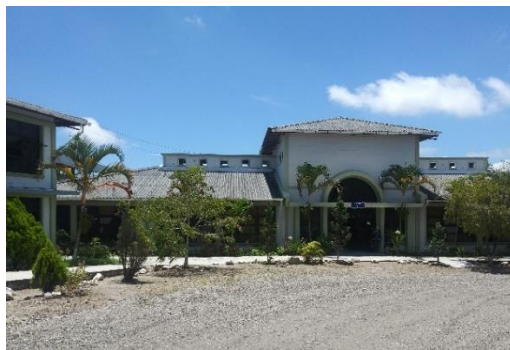
Fotografía No. 5. Edificio N°2
