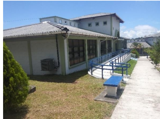
Fotografía No. 4. Edificio N°1
