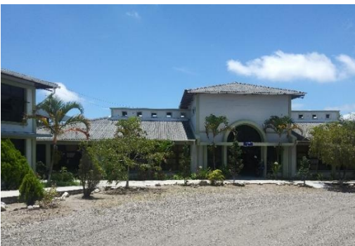
Fotografía No. 5. Edificio N°2
