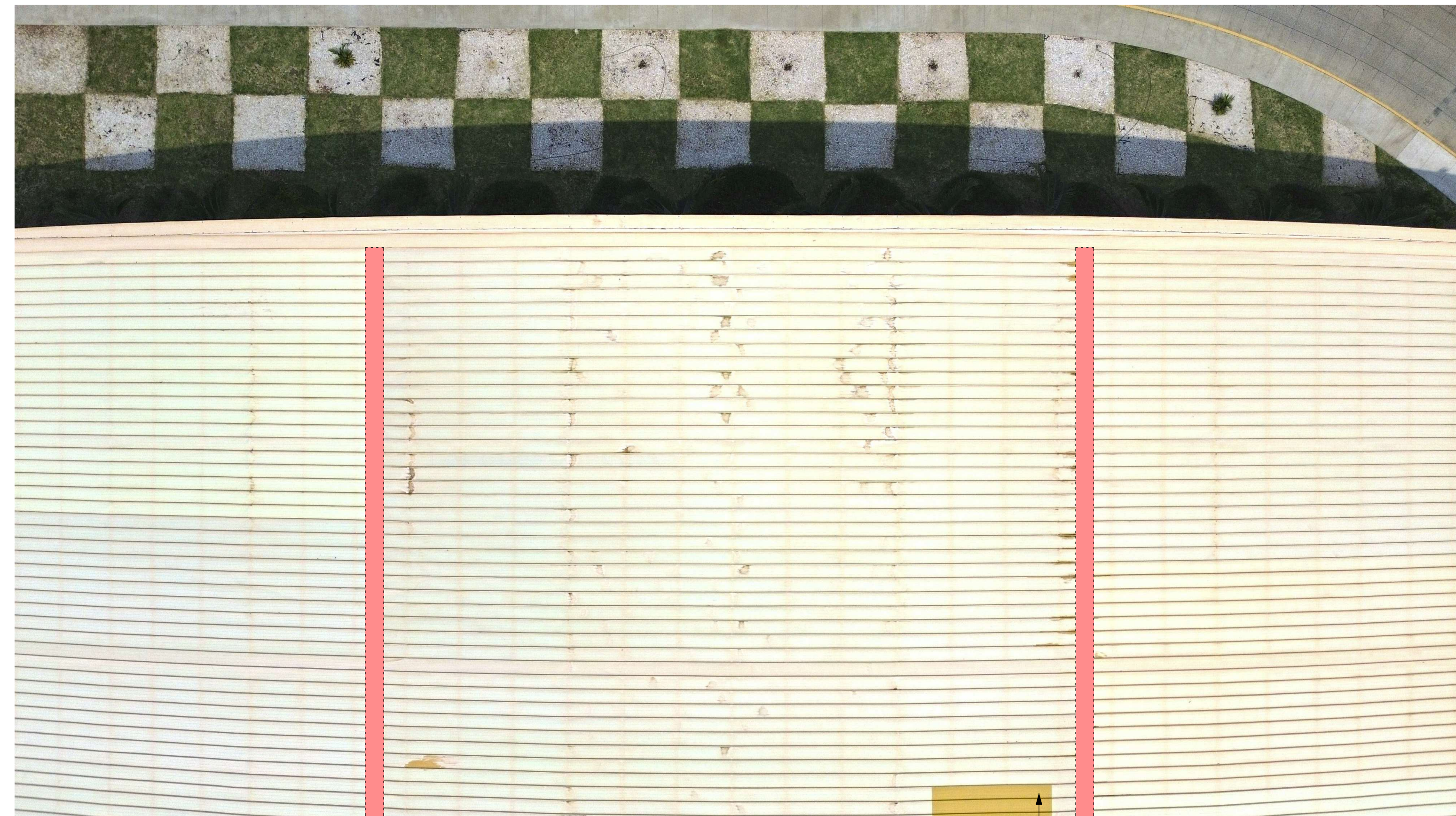
ILUSTRACIÓN ZONA DE TRASLAPES Y APLICACIÓN DE SELLO DE IMPERMEABILIZACIÓN
