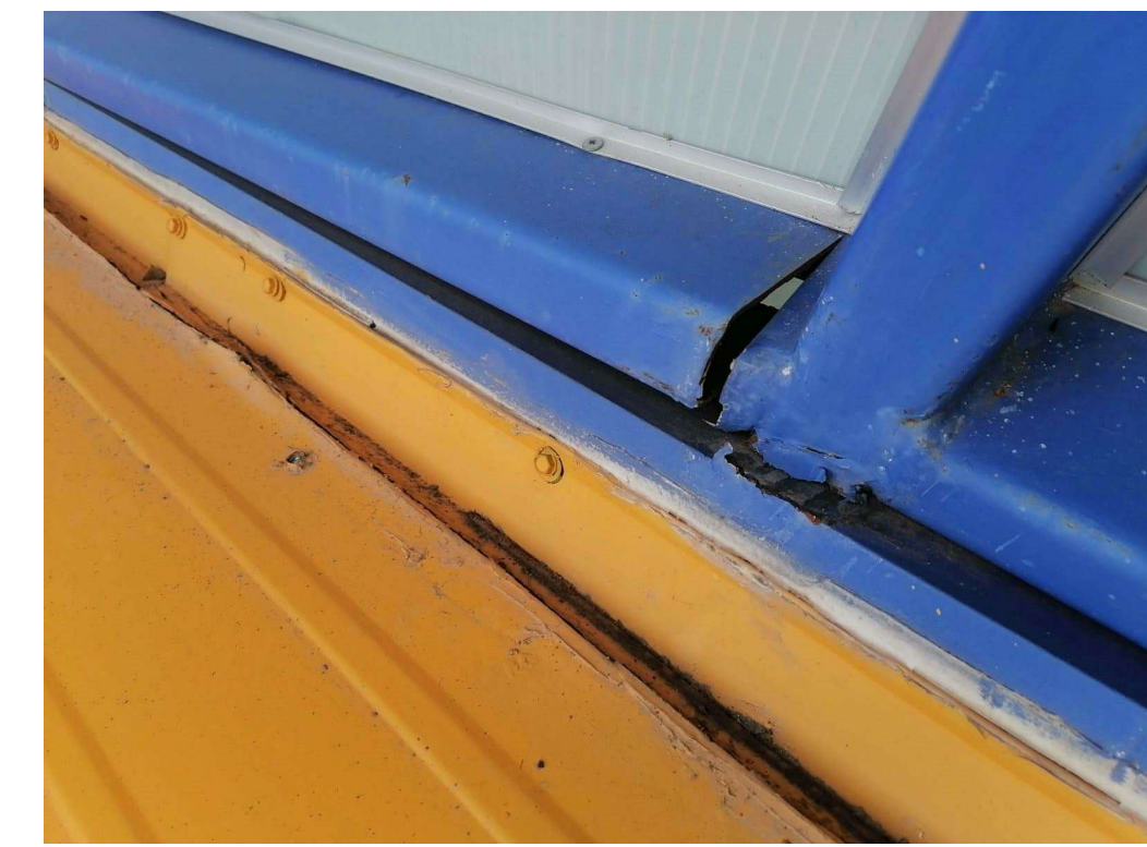
ILUSTRACIÓN PUNTO DE REFUERZO Y APLICACIÓN DE SELLO DE IMPERMEABILIZACIÓN
