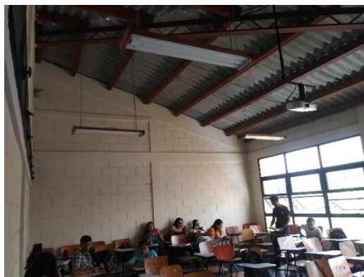
Fotografía N° 2. Aula en segundo nivel del Edificio N° 1
