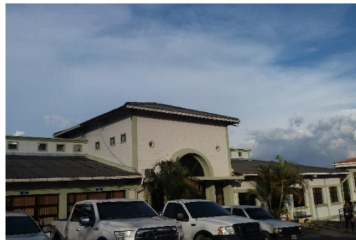
Fotografía No. 6. Edificio N°3
