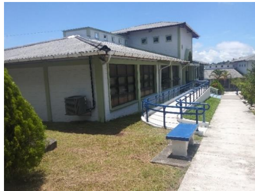
Fotografía No. 4. Edificio N°1
