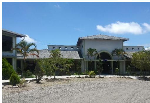
Fotografía No. 5. Edificio N°2
