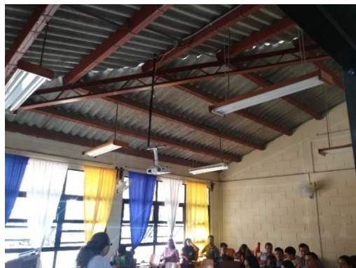
Fotografía No. 3. Aula en Edificio N° 2
