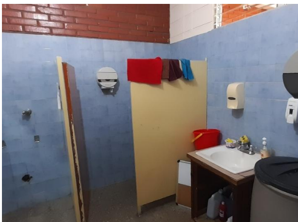
Fotografía N° 7. Baño de Hombres, Oficinas Decanato, Tercer Nivel.
