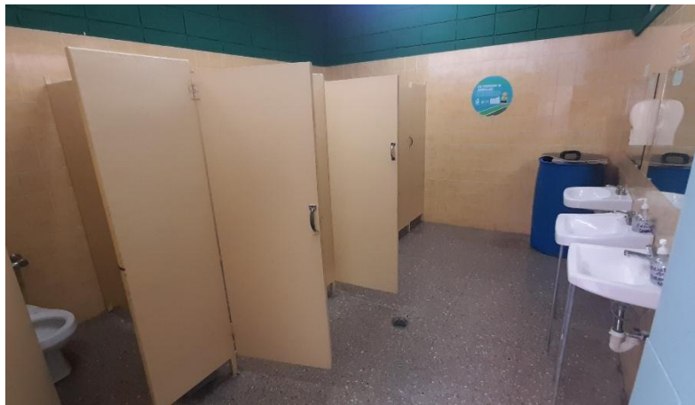
Fotografía N° 6. Módulo Sanitario de Mujeres, Tercer Nivel.
