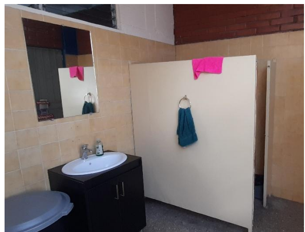
Fotografía N° 8. Baño de Mujeres, Oficinas Decanato, Tercer Nivel.
