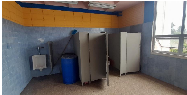
Fotografía N° 4. Módulo Sanitario de Hombres, Segundo Nivel.
