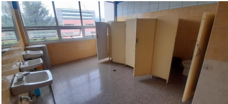
Fotografía N° 3. Módulo Sanitario de Mujeres, Segundo Nivel.
