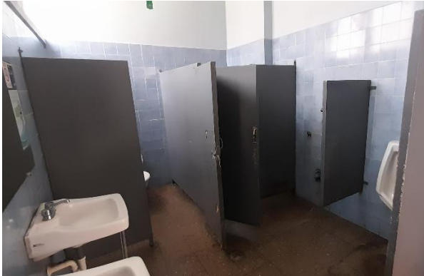
Fotografía N° 1. Módulo Sanitario de Hombres, Primer Nivel.
