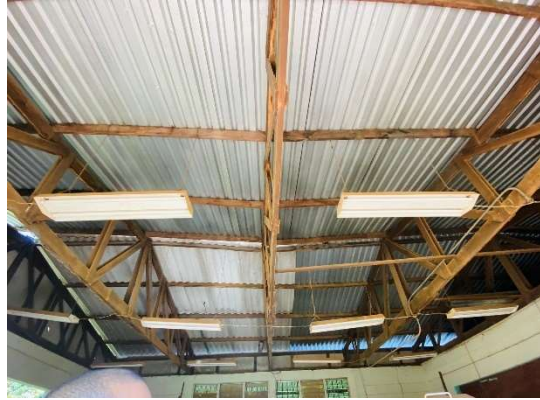
Fotografía 6 Estructura de techo, Taller de Carpintería.
