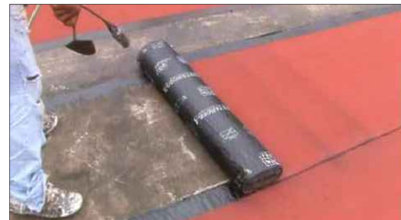
SISTEMA DE IMPERMEABILIZACIÓN A APLICAR EN LOSAS
