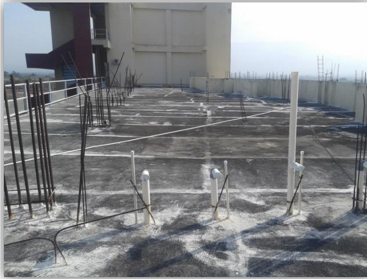
LOSA EXISTENTE A IMPERMEABILIZAR
