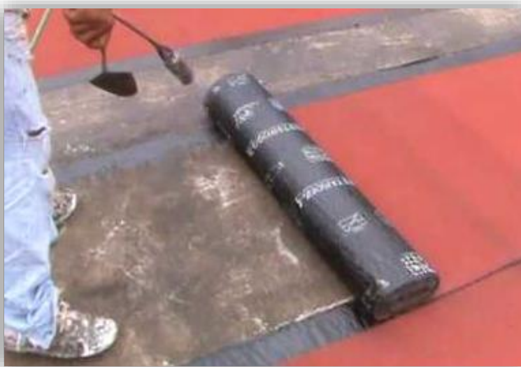
SISTEMA DE IMPERMEABILIZACIÓN A APLICAR EN LOSAS
