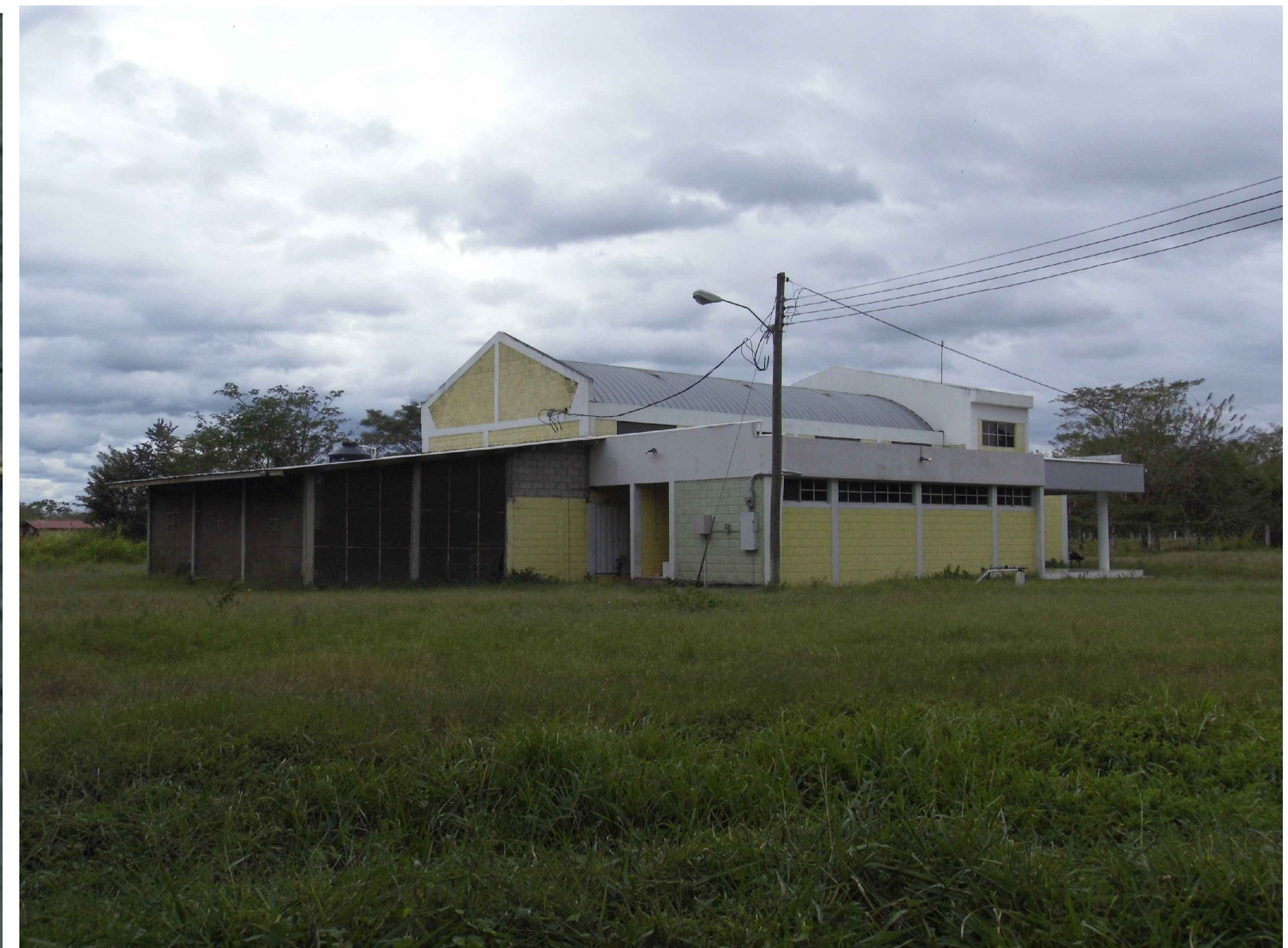
VISTA EXTERIOR ACTUAL ESC:-----N/A
