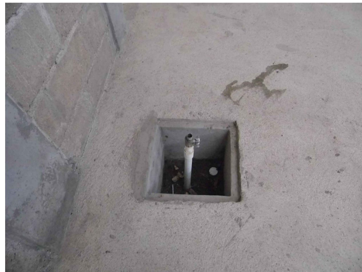
PUNTOS SANITARIOS SIN USO DEBEN SER SELLADOS Y RELLENADAS LAS CAJAS CON MATERIAL SELECTO COMPACTADO Y COLOCACION DE PISO Y REVESTIMIENTO
