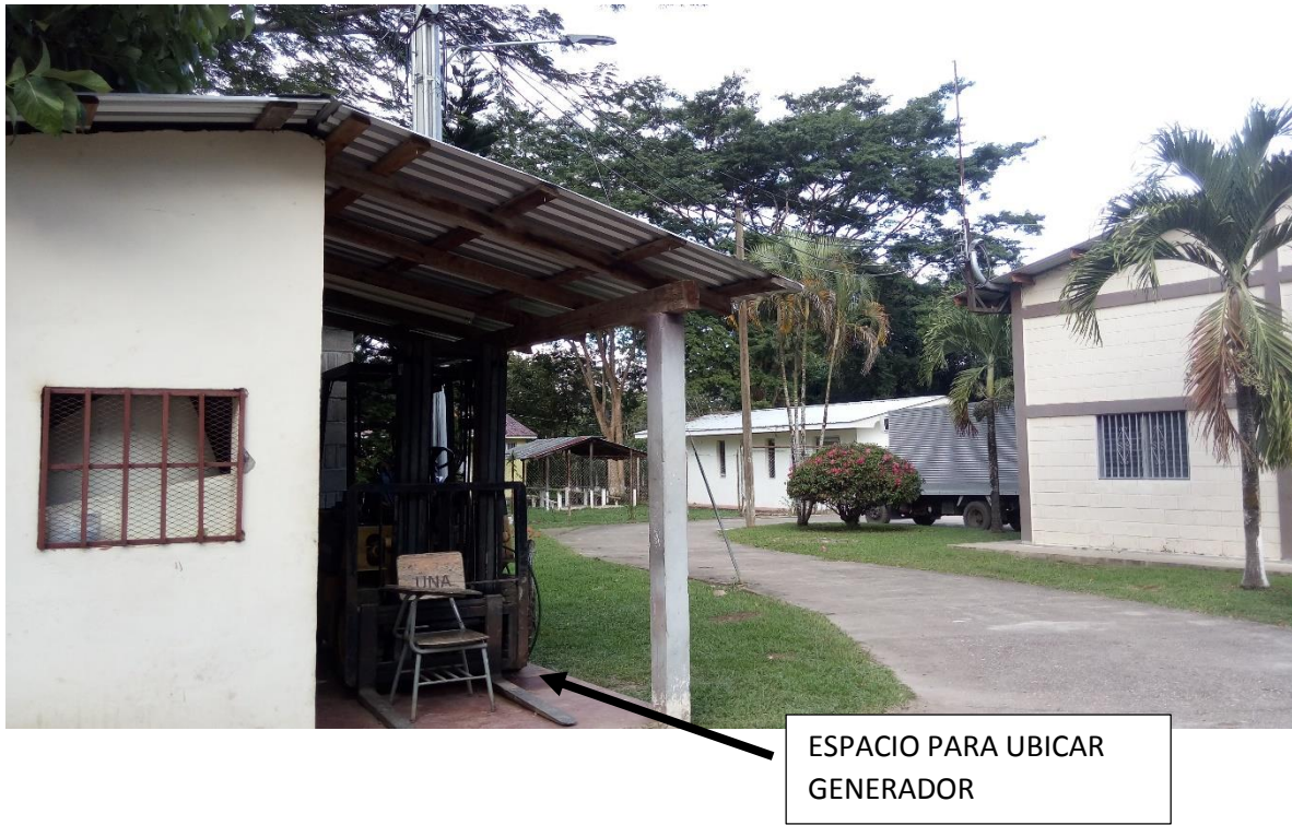
Ilustración 1: VISTA SUR DE CASETA EXISTENTE
