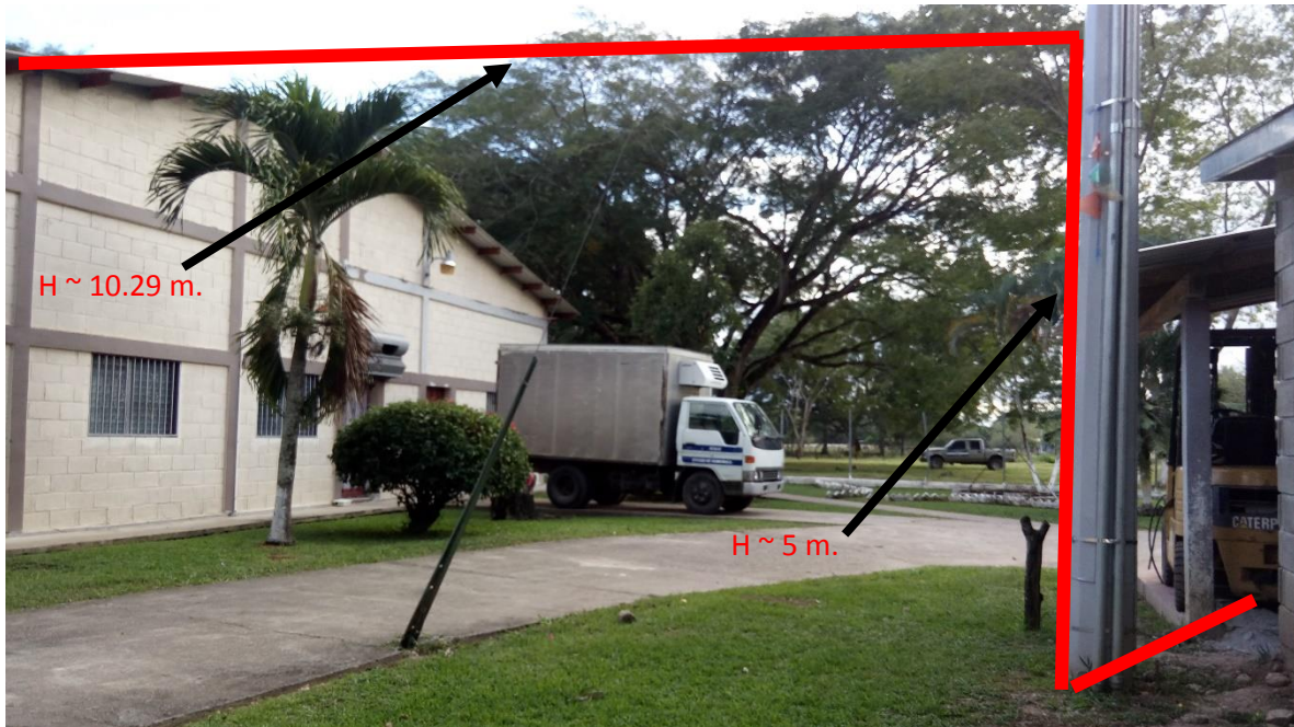
Ilustración 3: RUTA SUGERIDA PARA CABLEADO
