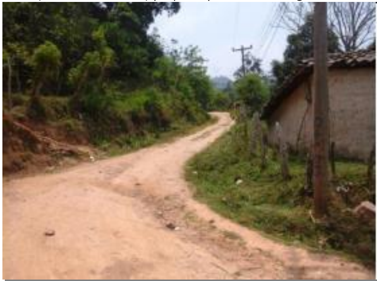
Fotografía No.1: inicio del tramo. Se necesita perfilar calzada.
