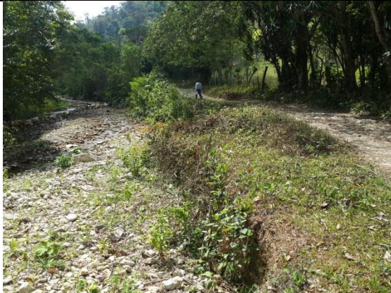
Estación 1+130 Relleno para mejorar calzada, muro de gaviones lado izquierdo.
