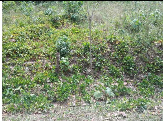
Estación 2+500 Alcantarilla enterrada y construcción del tragante.
