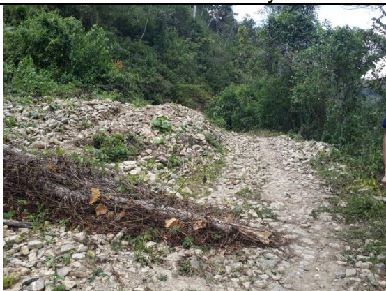
Estación 1+790 Derrumbe de material, Construcción de muro de gaviones
