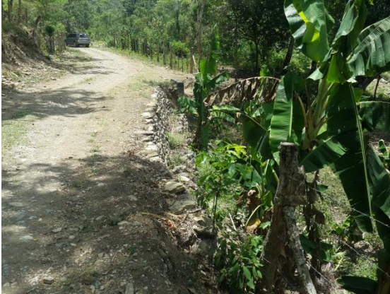
Estación 2+920 Muro seco existente.
