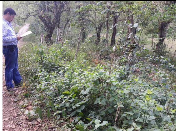
Estación 0+930 Salida de Agua en cafetal lado derecho.
