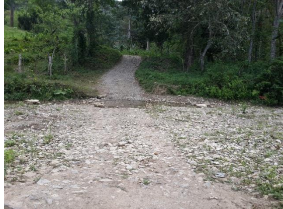
Estación 2+030 Construcción de Vado Sumergible.
