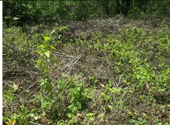
Estación 3+020 Alcantarilla enterrada, canalizar salidas y enchapar
