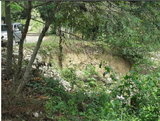
Estación 1+330 Construcción de muro de gaviones.
