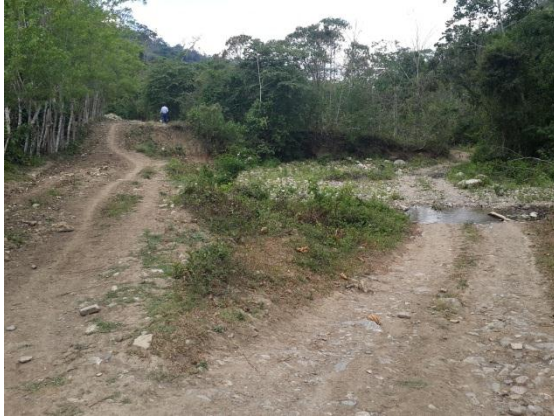
Estación 1+820 Socavación del camino causado por el cauce de la quebrada.
