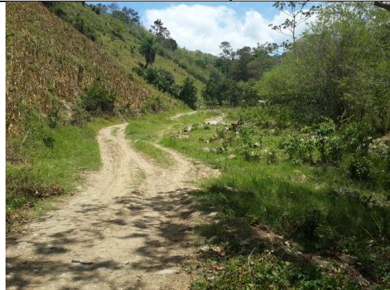
Estación 3+510 Canalización o dragado de quebrada.
