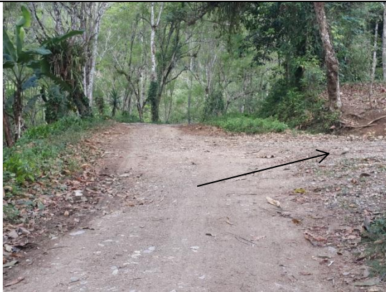
Estación 0+830 Relleno para mejorar calzada desvió de San Marcos.
