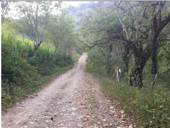
Estación 0+980 Relleno para mejorar calzada por existencia de cafetal
