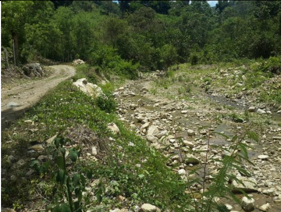
Estación 2+960 Muro de Mampostería
