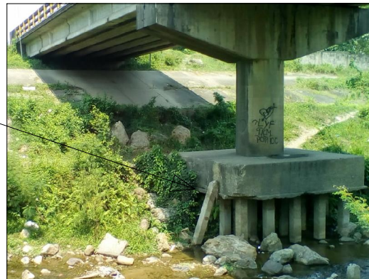
EROSION EN PILASTRAS
