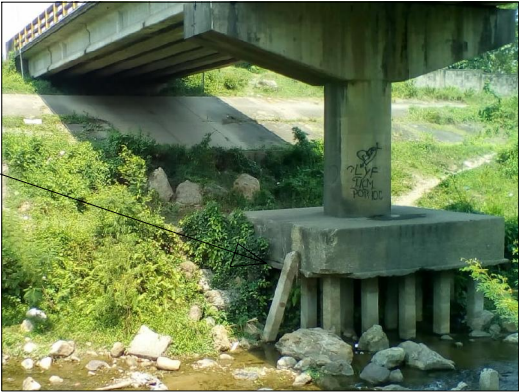
EROSION EN PILASTRAS
