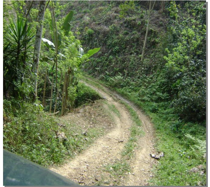
Fotografía No.2: Necesidad de Enchape de cunetas.
