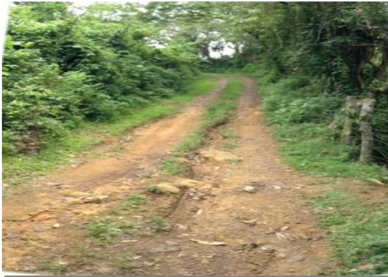
Fotografías No.3: empedrado de cuneta.
