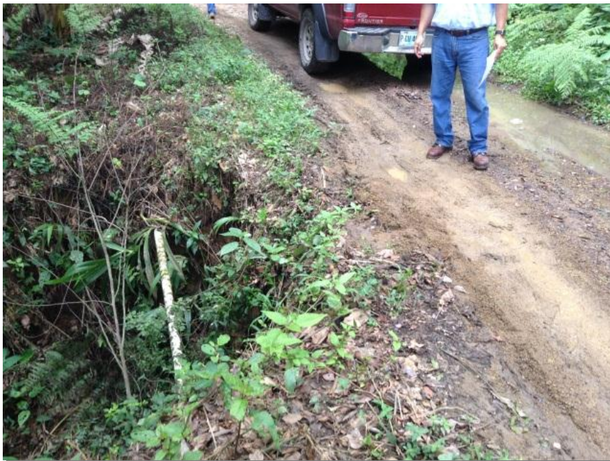
Fotografía No.1: instalar alcantarilla nueva.
