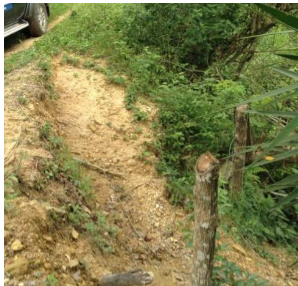
Fotografía No.5: Taludes a estabilizar.
