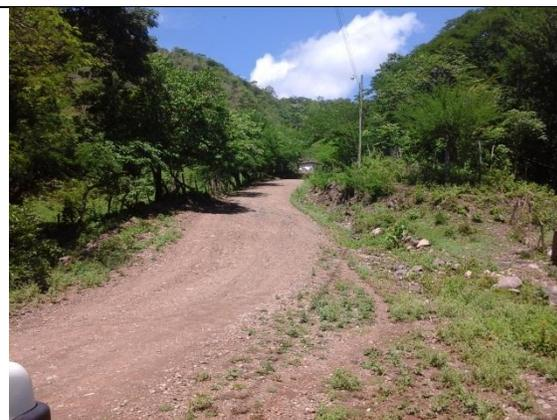
2+550 vista de las condiciones del camino en donde se deben de tener cunetas enchapadas o con disipadores de energía para controlar la velocidad del agua
