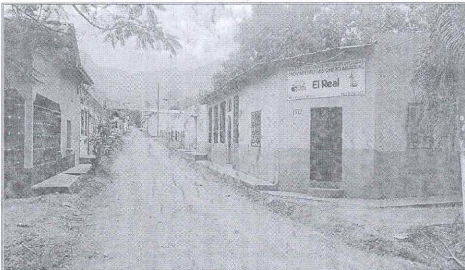
Inicio del tramo
