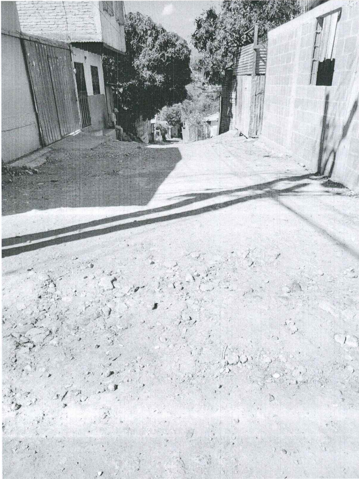
CALLE A PAVIMENTAR
