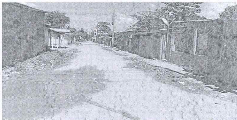
Vista de situación actual de la calle a tratar
