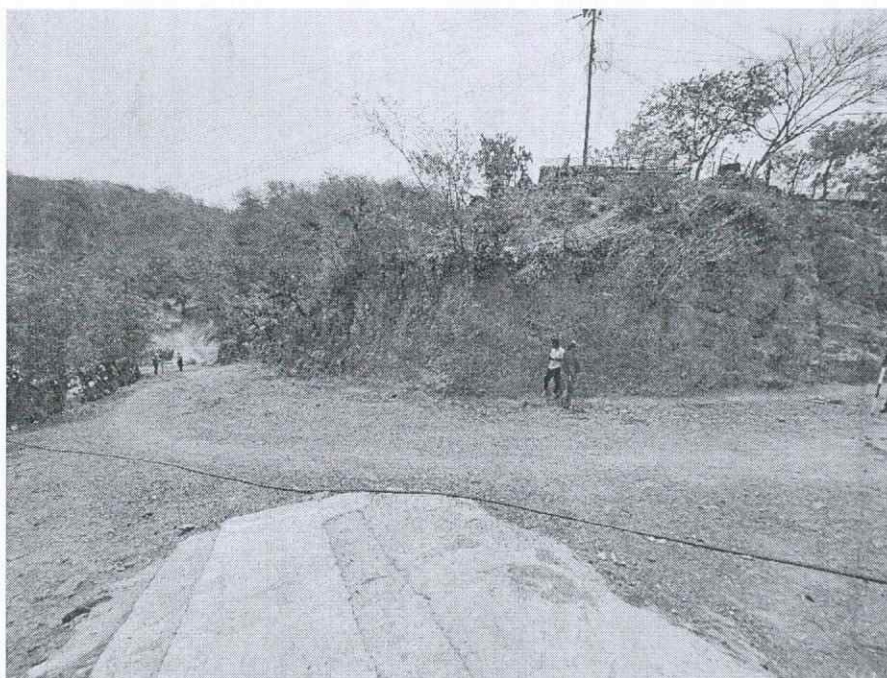
Imagen 8. Punto final del Pavimento
