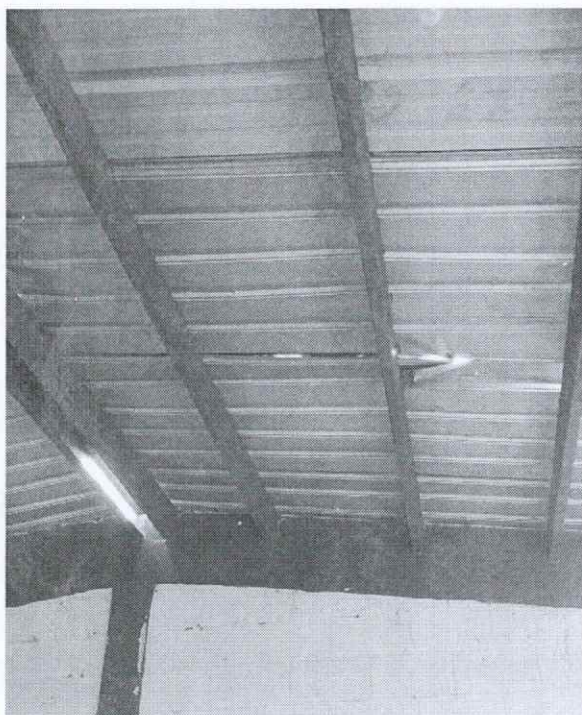
Lamina de aluzinc en mal estado, y su estructura de canaleta en buen estado.
