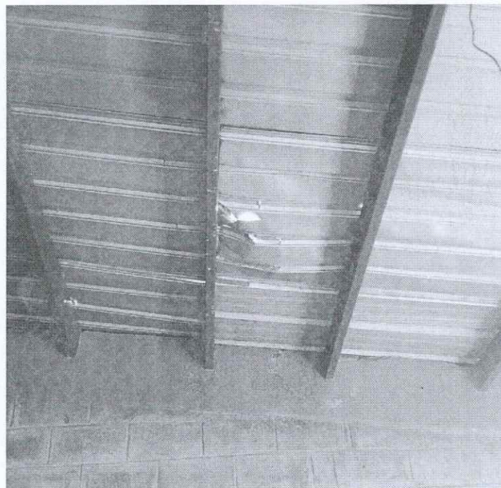
Lamina de aluzinc en mal estado, y su estructura de canaleta en buen estado.
