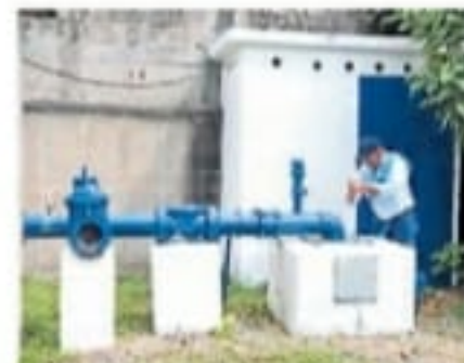
SERVICIO. Un trabajador de ASP supervisa un pozo.
