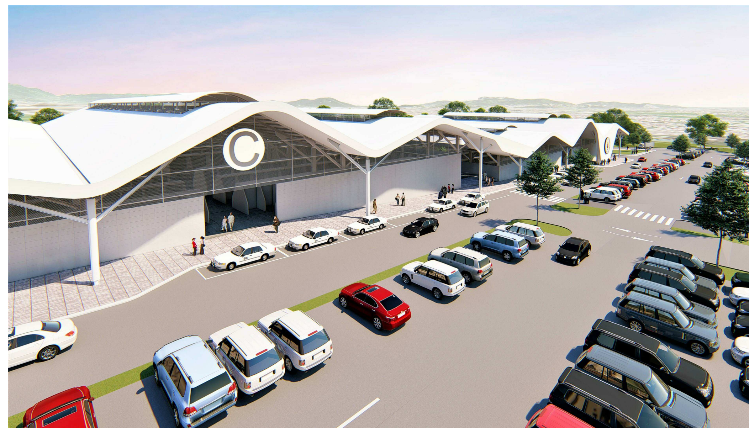
Imágen 03 - Nave C
