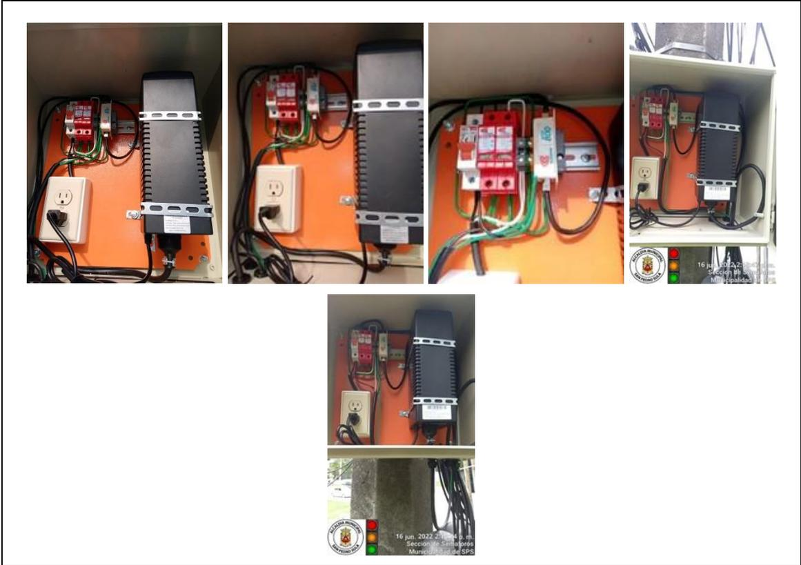
**SUMINISTRO E INSTALACIÓN DE CONEXIÓN:** SUMINISTRO DE SISTEMA DE ATERRIZAJE 3 VARILLAS Y CONDUCTOR DE COBRE DESNUDO #2 HASTA EL PANEL Y SOLDADURA EXOTÉRMICA, REVISIÓN HE INSTALAR RED NUEVA DE CONEXIÓN A TIERRA EXISTENTE MENOR A 5 OHMS
