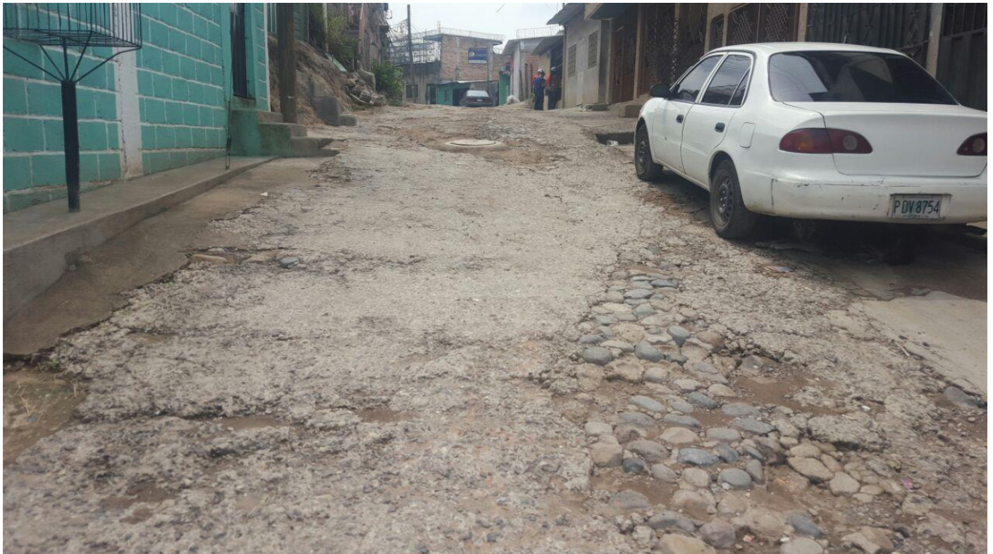
Fin de la calle a pavimentar
