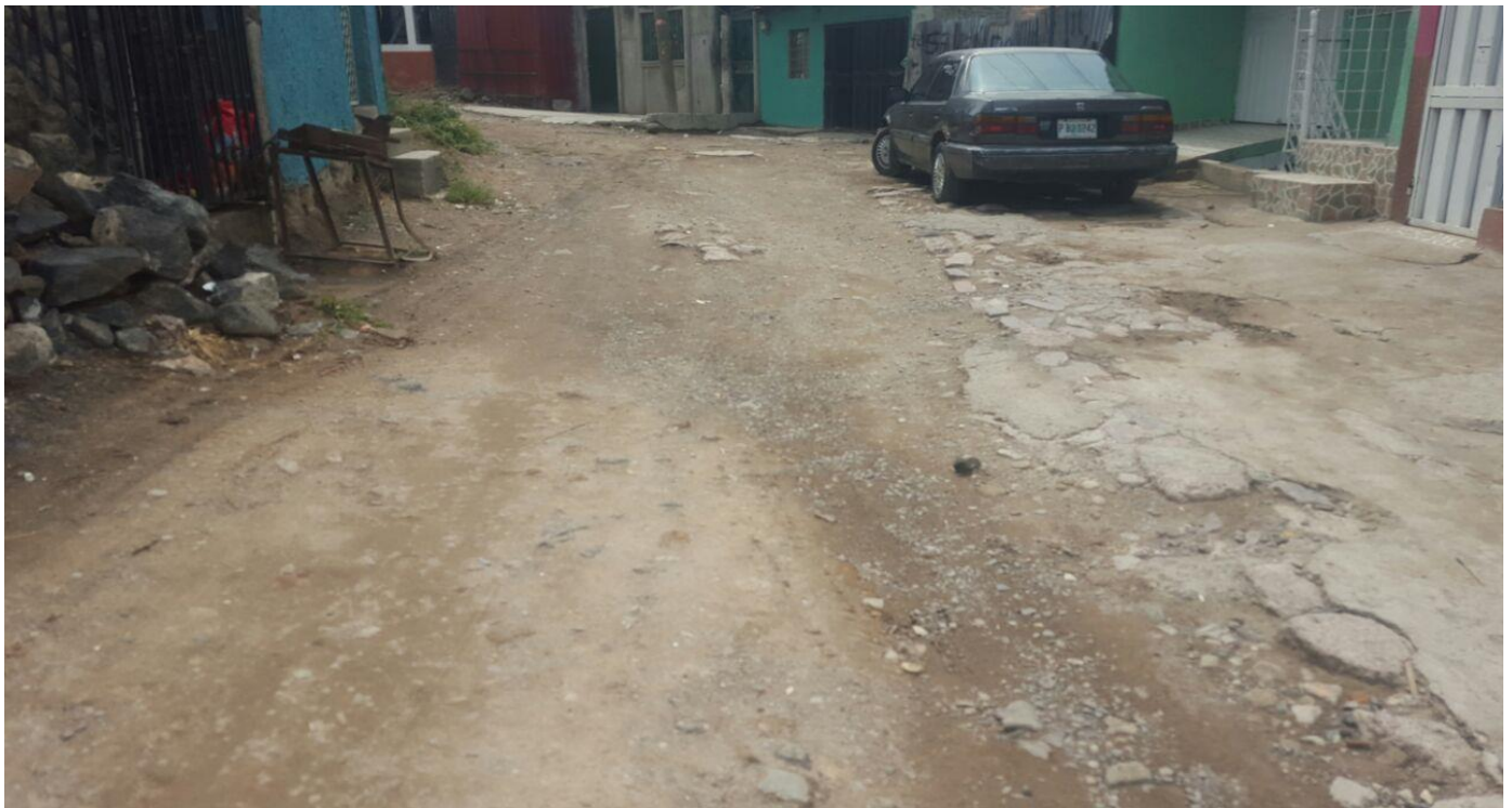
Vista de calle a pavimentar
