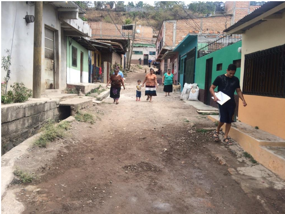
Foto 4. Vista panorámica pavimentación
