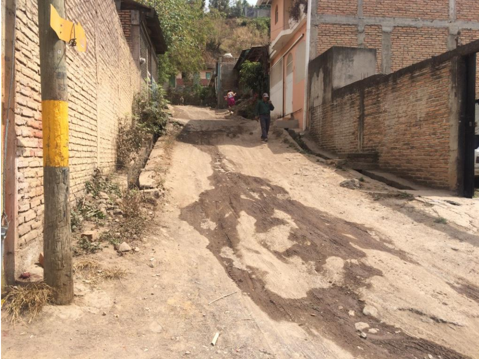
Foto 3. Vista panorámica pavimentación
