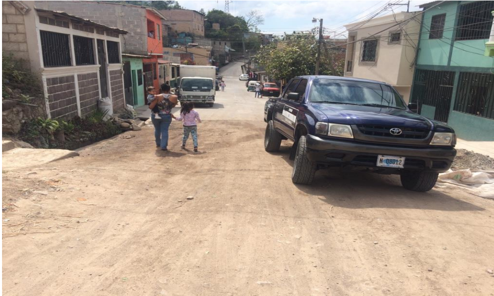
Foto 1. Vista de pavimento existente, inicio de pavimentación
