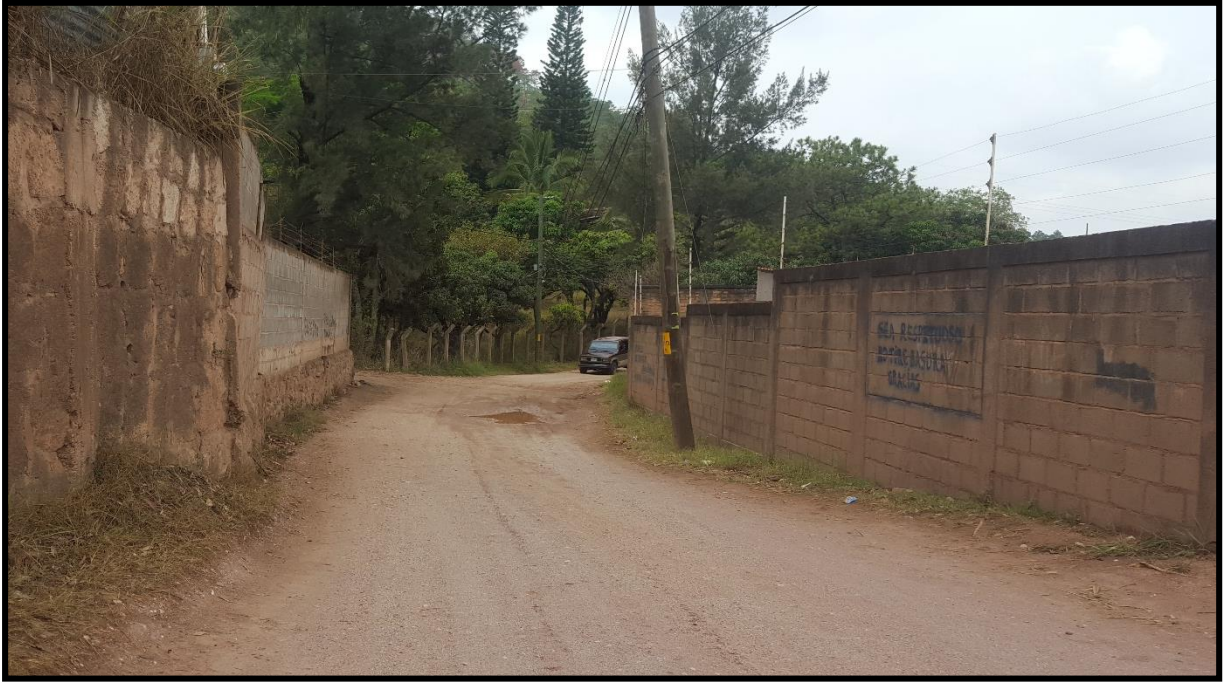
Inicio del tramo a reparar
