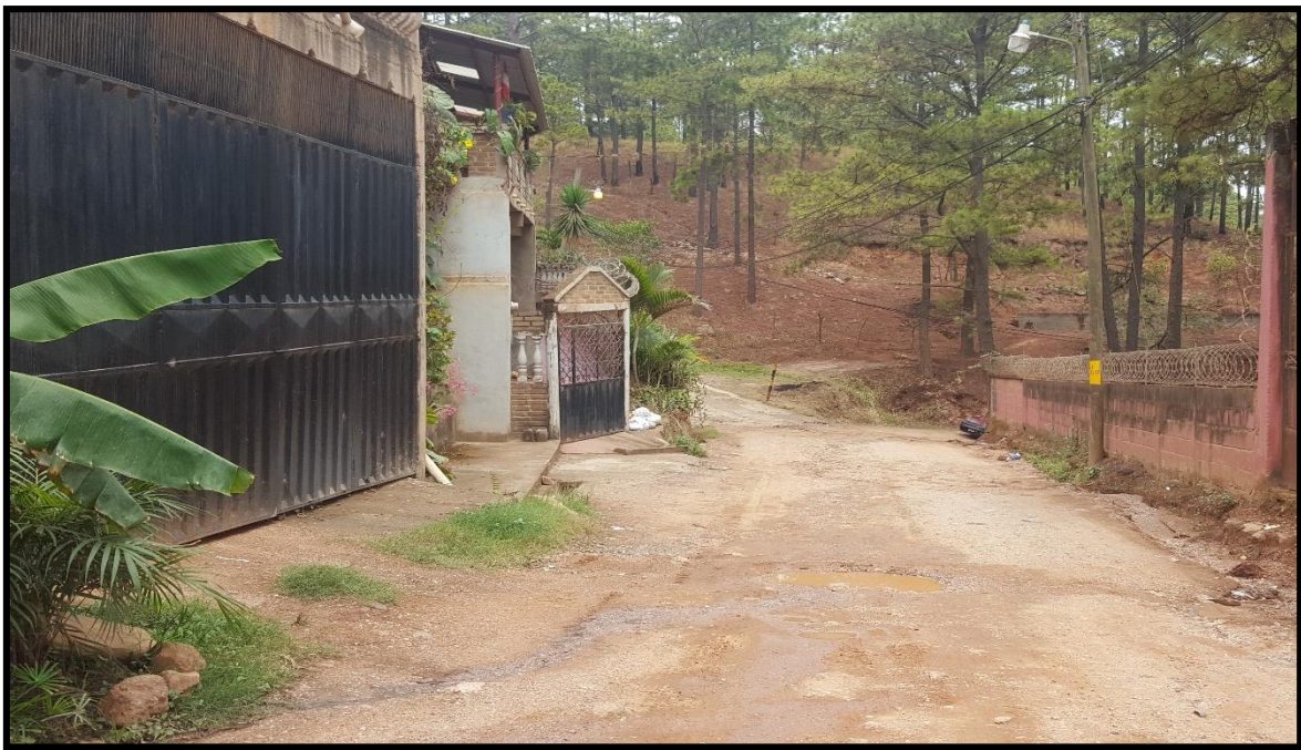
Vista panorámica del tramo en mal estado
