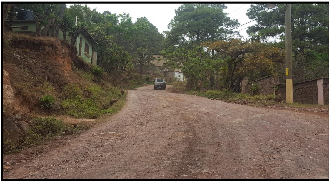
Vista del final del tramo
