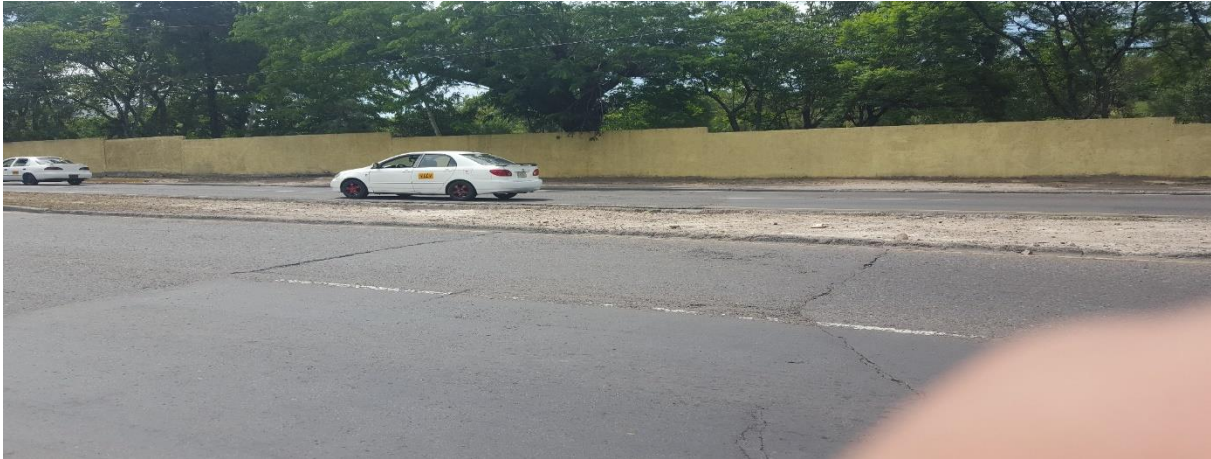
TRAMO 1: COL. 21 DE FEBRERO, FRENTE A CAMPO DE GOLF COUNTRY CLUB.
