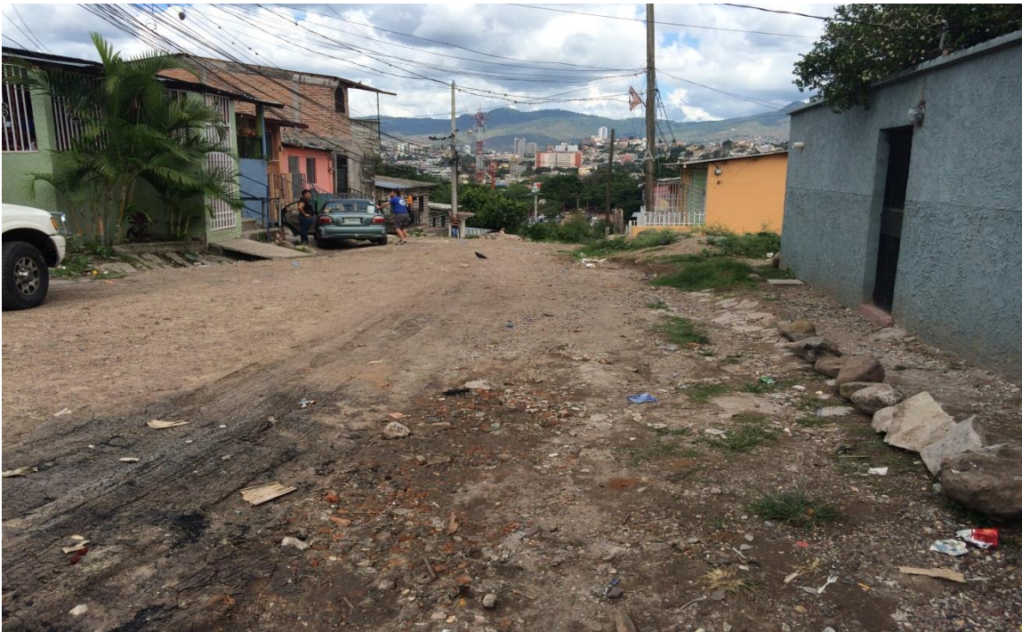
Vista panorámica de la calle a pavimentar
