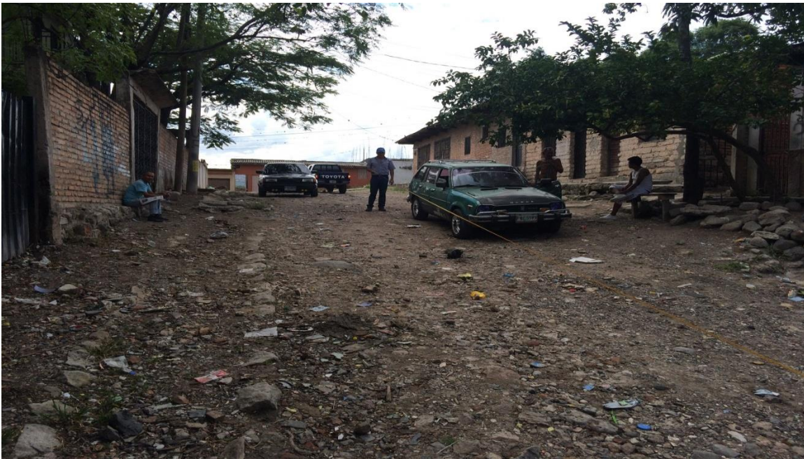
Fin de calle a pavimentar
