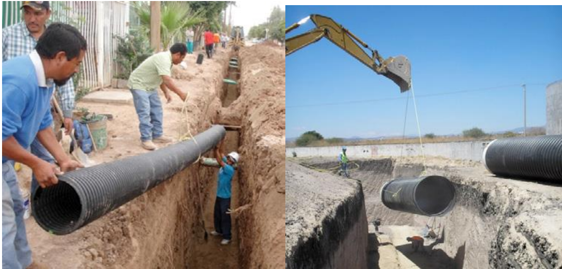
Bajado manual y con maquinaria de tubería a la zanja, y usar dos puntos de sujeción.
