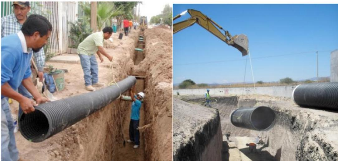
Bajado manual y con maquinaria de tubería a la zanja, y usar dos punto de sujeción.
