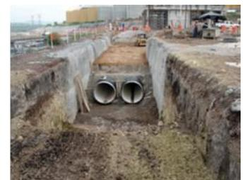
La supervisión de la obra deberá llevar registros de deflexión del tubo durante el proceso de instalación para diámetros de 36" o mayores, especialmente durante las primeras pasadas del equipo de compactación, a fin de garantizar el adecuado comportamiento mecánico de la tubería. La deflexión no deberá exceder el 5% del diámetro interior del tubo.
