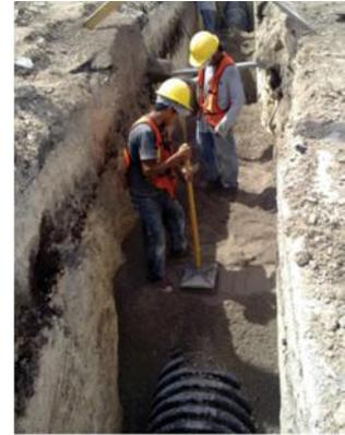
Este relleno inicial debidamente compactado y terminado tendrá la capacidad de soportar cargas vehiculares H-20 (9 ton/eje).
