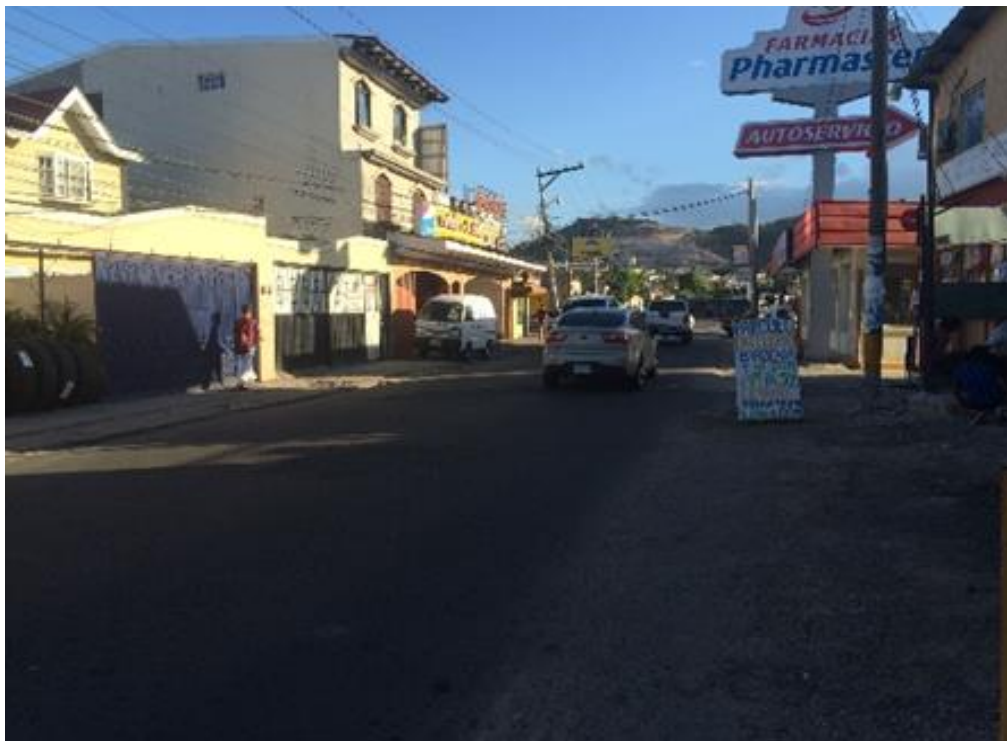
Tramo hacia fuerza Aérea. Falta de señalamiento vertical y horizontal
