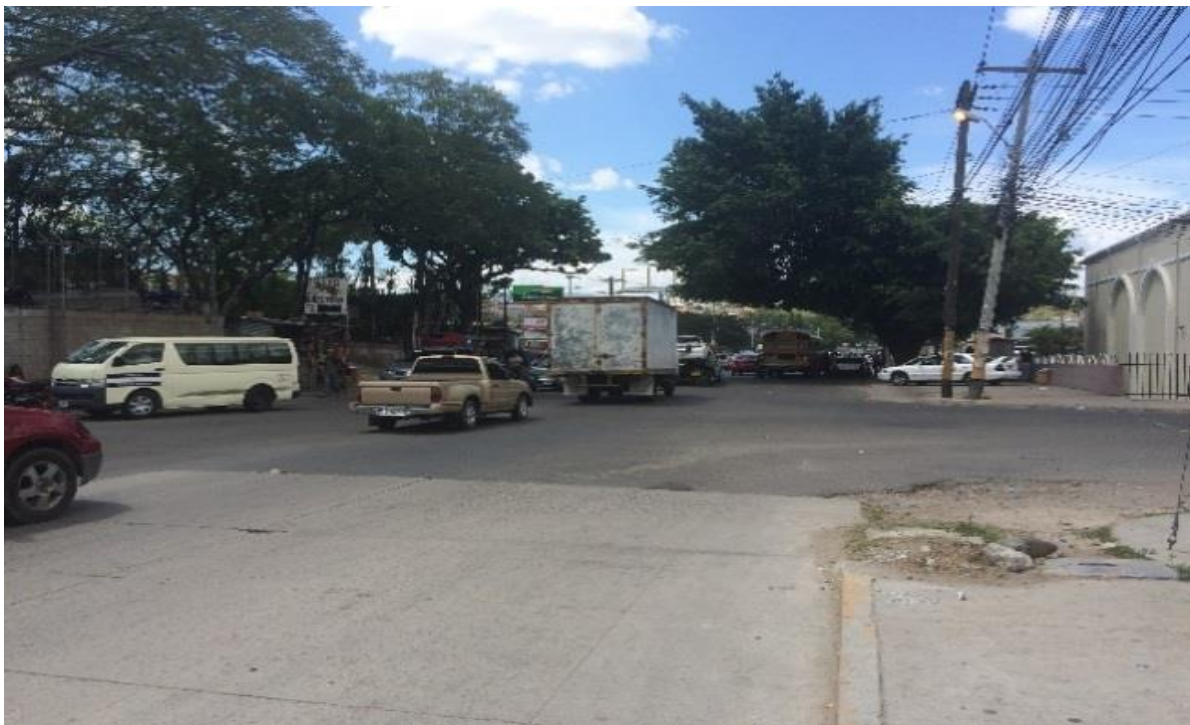
Carretera salida al sur .Se observan Aceras en mal estado
