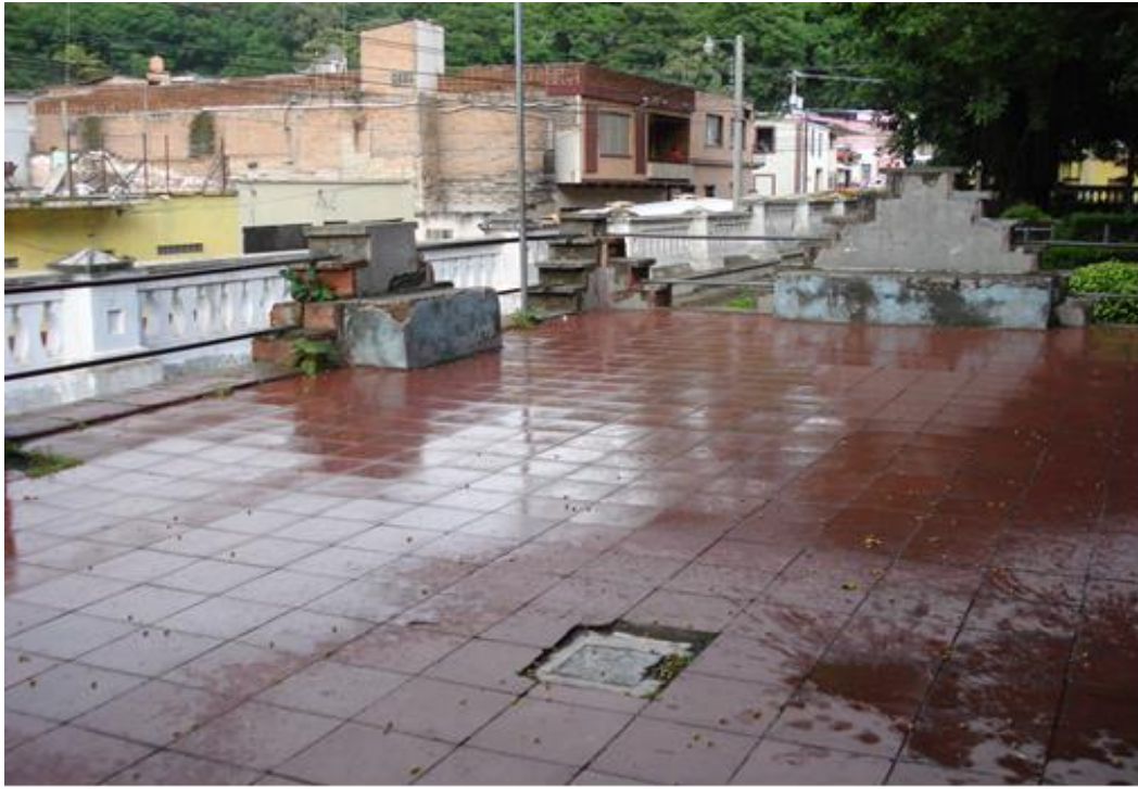
VISTA DEL PISO DE TERRAZA
