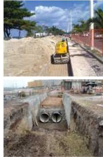
La supervisión de la obra deberá llevar registros de deflexión del tubo durante el proceso de instalación para diámetros de 36" ó mayores, especialmente durante las primeras pasadas del equipo de compactación, a fin de garantizar el adecuado comportamiento mecánico de la tubería. La deflexión no deberá exceder el 5% del diámetro interior del tubo.
