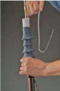
Paso 7. Coloque la terminal sobre el cable.
