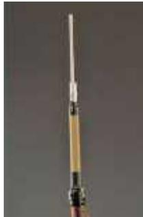
PASO 1. Ponga el cable en posición y corte el largo. Usando las prácticas estándar, corte la tira o lengüeta del cable, la pantalla metálica, pantalla semiconductor y el aislamiento del cable mostrando el conductor.
