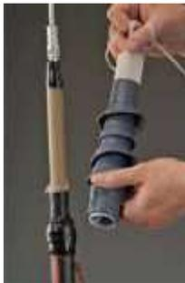
Paso 6. Jale la cuerda final suelta del núcleo, hasta que coincida con el final del encapsulado de la terminal gris.
