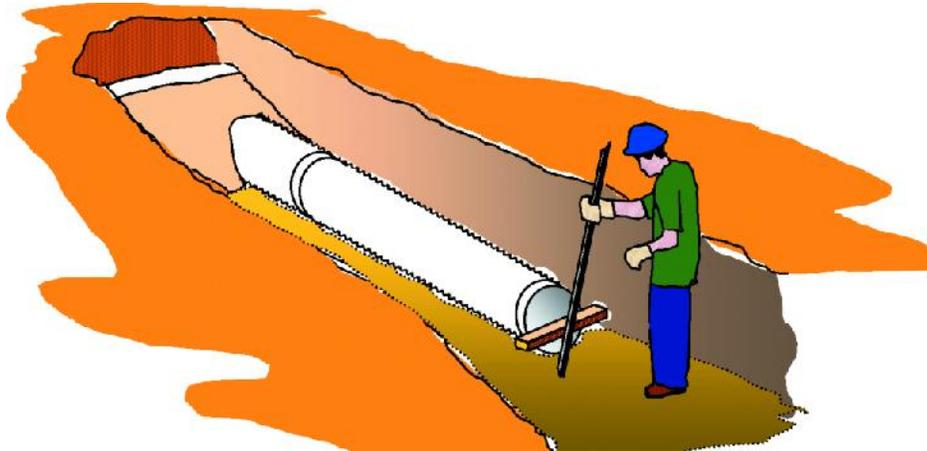
4. La tubería de PVC de junta rápida se suministra en longitudes de 6.0 m, sin embargo es frecuente cortarla para alcanzar las longitudes exactas de cada tramo, o para colocar accesorios. Los cortes deben hacerse lo más recto posible, siempre en los valles. A continuación elimine los rebordes con una lima.
