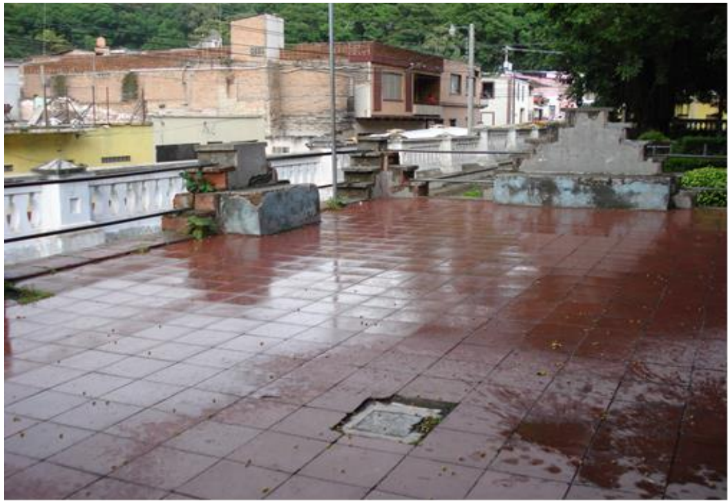
VISTA DEL PISO DE TERRAZA
