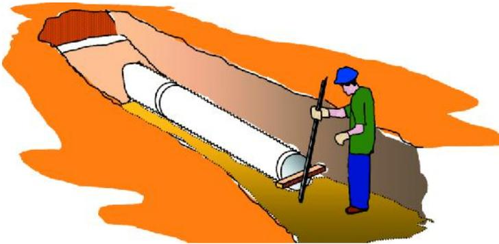
4. La tubería de HDPE de junta rápida se suministra en longitudes de 6.0 m, sin embargo, es frecuente cortarla para alcanzar las longitudes exactas de cada tramo, o para colocar accesorios. Los cortes deben hacerse lo más recto posible, siempre en los valles. A continuación, elimine los rebordes con una lima.
