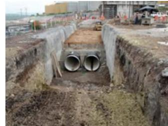
La supervisión de la obra deberá llevar registros de deflexión del tubo durante el proceso de instalación para diámetros de 36" ó mayores, especialmente durante las primeras pasadas del equipo de compactación, a fin de garantizar el adecuado comportamiento mecánico de la tubería. La deflexión no deberá exceder el 5% del diámetro interior del tubo.
