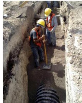
El material producto de excavación se podrá utilizar como material de relleno inicial cuando cumple con la clase de Suelos I a IV. Para la compactación del relleno inicial, se podrá utilizar equipo ligero como pisón de mano, pisón mecánico (bailarina) o placa vibratoria.
