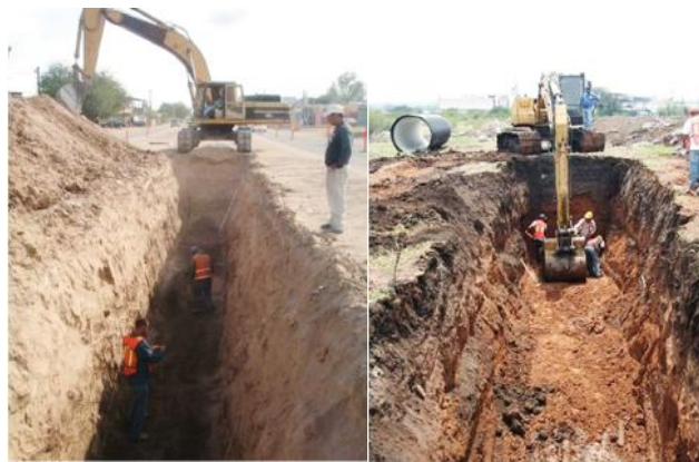
Excavación de la zanja
