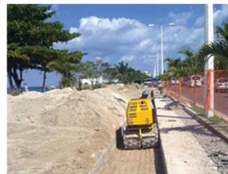
La compactación deberá mantenerse como se especifica, a fin de dar rigidez al sistema suelo-tubo y a la capa de rodamiento. En la zanja deberá compactarse con equipo ligero, ver Figura. En caso de terraplenes, se podrá utilizar maquinaria.
