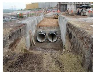
La supervisión de la obra deberá llevar registros de deflexión del tubo durante el proceso de instalación para diámetros de 36” ó mayores, especialmente durante las primeras pasadas del equipo de compactación, a fin de garantizar el adecuado comportamiento mecánico de la tubería. La deflexión no deberá exceder el 5% del diámetro interior del tubo.
