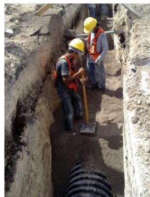
El material producto de excavación se podrá utilizar como material de relleno inicial cuando cumple con la clase de Suelos I a IV. Para la compactación del relleno inicial, se
