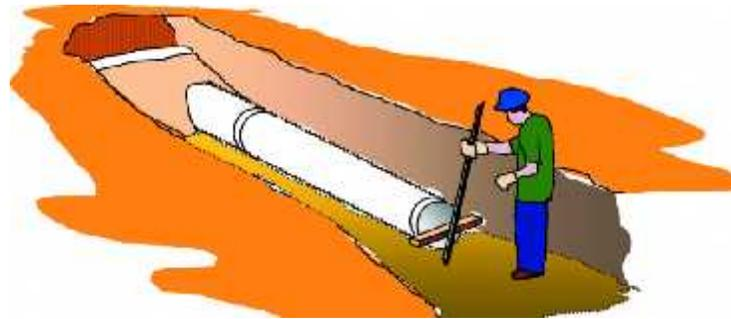
4. La tubería de HDPE de junta rápida se suministra en longitudes de 6.0 m, sin embargo, es frecuente cortarla para alcanzar las longitudes exactas de cada tramo, o para colocar accesorios. Los cortes deben hacerse lo más recto posible, siempre en los valles. A continuación, elimine los rebordes con una lima. La tubería a utilizar deberá cumplir con la norma ASTM-949
