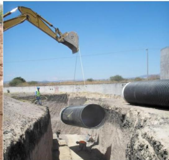
Bajado manual y con maquinaria de tubería a la zanja, y usar dos puntos de sujeción.
