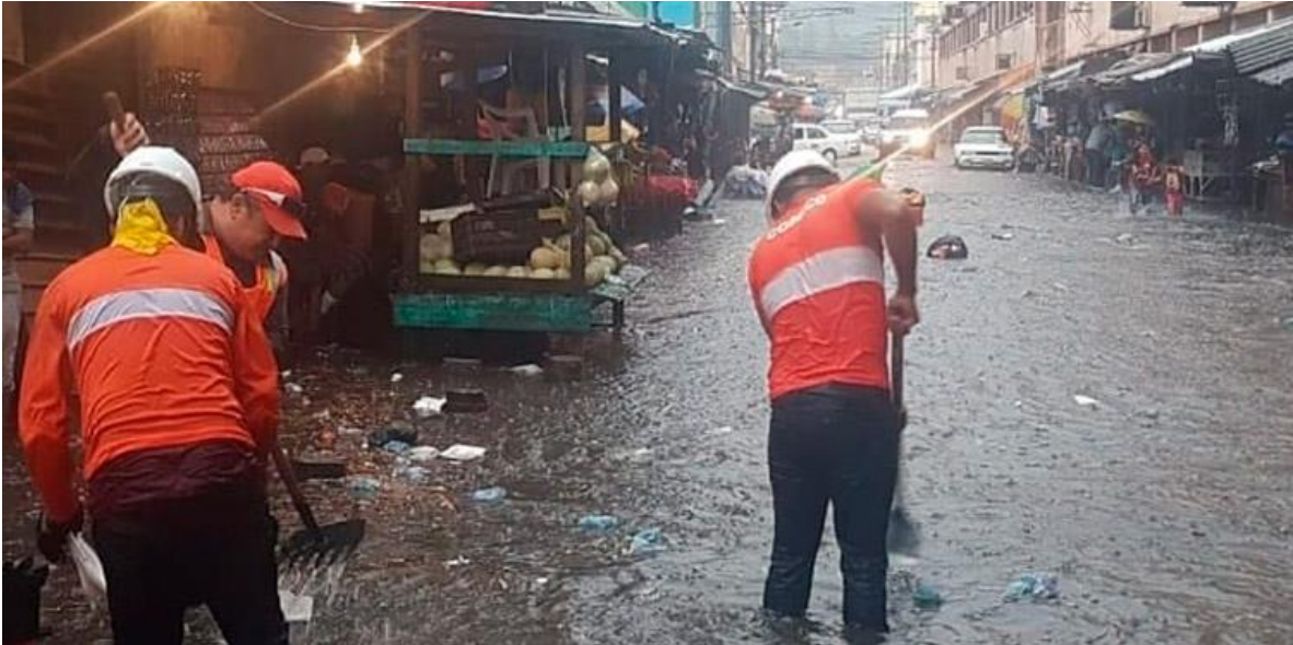
En la imagen se muestra la problemática por inundaciones de calles y avenidas en diferentes puntos del Distrito Central
