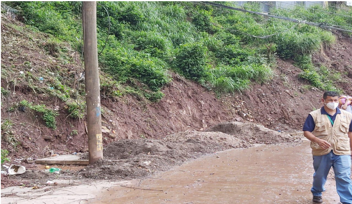
En la imagen se muestra los problemas de inestabilidad de taludes en diferentes zonas del Distrito Central
