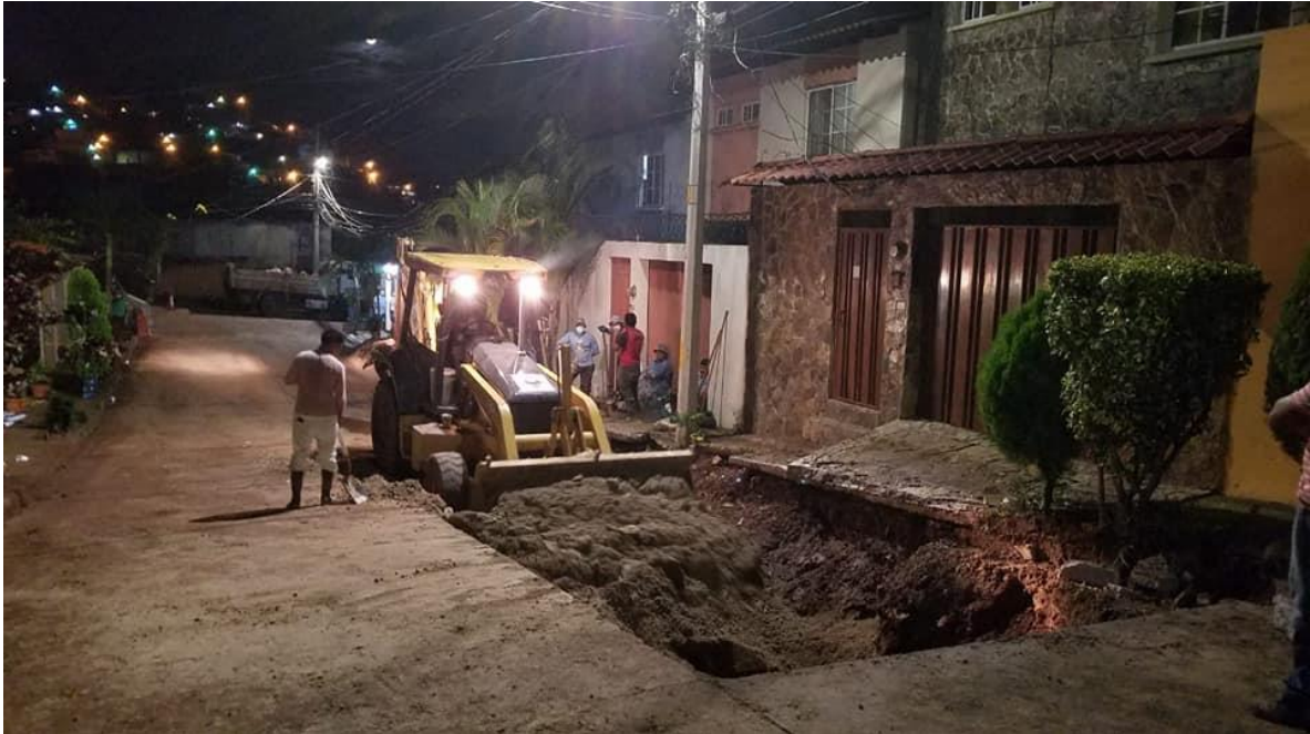
En la imagen se muestra las labores de reparación de daños ocurridos por las tormentas en el Distrito central
