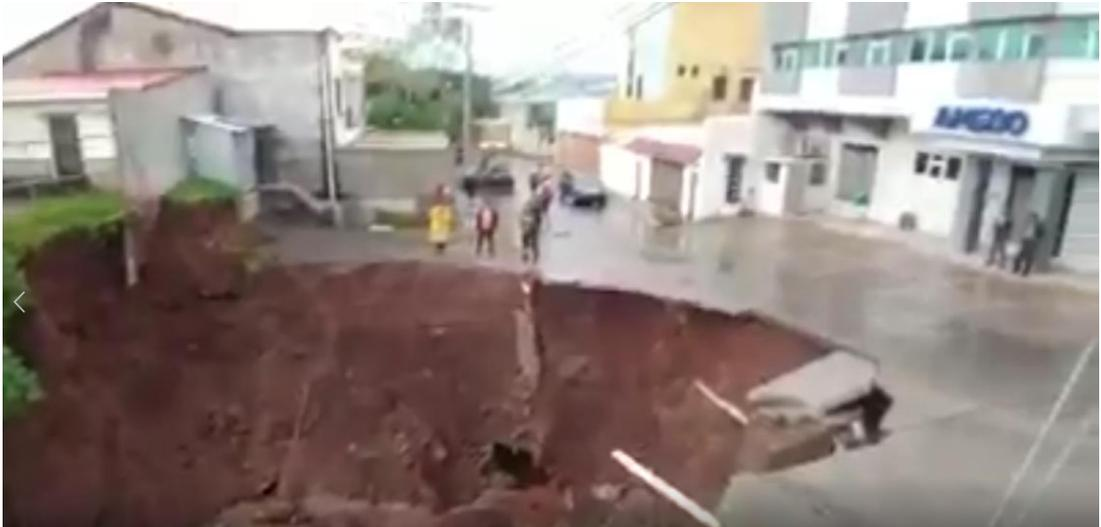
En la imagen se puede apreciar la socavación del sub suelo producto de las altas precipitaciones suscitadas en el Distrito central y drenajes obstruidos por basura
