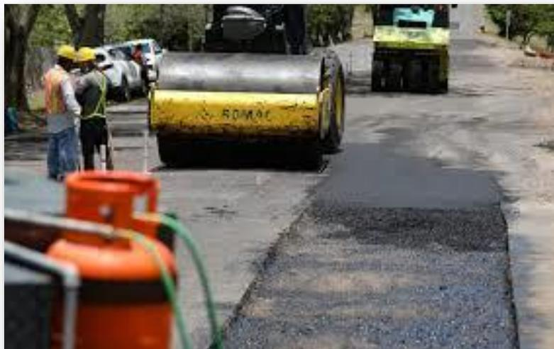
Compactado de mezcla asfáltica utilizando rodillo vibratorio y compactadora neumática
