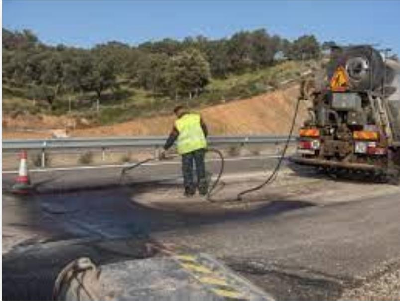
Colocación de Imprimación asfáltica previo a colocar mezcla.
