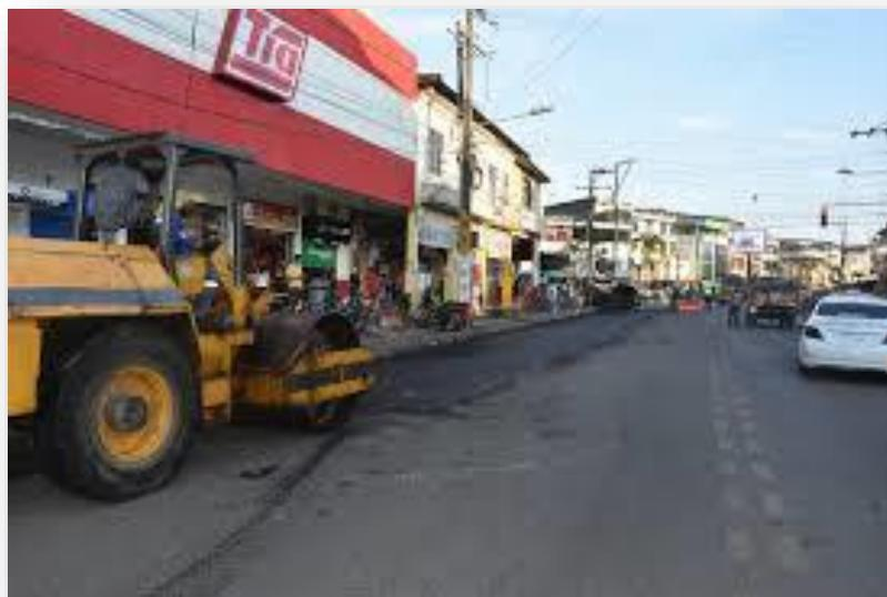
Compactación de la mezcla asfáltica con Compactadora vibratoria
